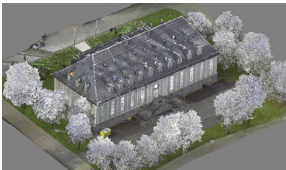
Aufnahme einer 3D-Punktwolke der Aula Academica der TU Clausthal mittels des terrestrischen Laserscanners Leica RTC360. Auch um solche Aufnahmen umsetzen zu können, ist der Rechencluster des SWZ um einen leistungsstarken Grafikprozessor erweitert worden. Foto: Institute of Geo-Engineering/TUC.
